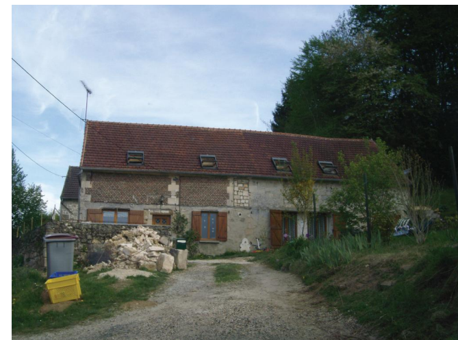
La conservation de l'intégrité des constructions constitue un enjeu comme en témoigne ce bâtiment, chemin de Carrieuse. Sa parties gauche a été partiellement reconstruite sans doute au début du XX e siècle comme en témoigne la présence de la brique. On remarque que la construction de droite est en pierre. Le bâtiment a été réenduit récemment, de façon partielle et sans doute avec un enduit comportant du ciment, inadapté aux anciennes constructions. Les ouvertures ont également été modifiées. L'ensemble a perdu sa cohérence.
