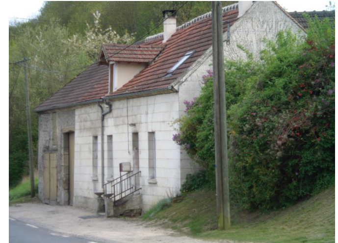
Les ravalements et matériaux de façades influent fortement sur la lecture des bâtiments. Ici, sur cet ensemble route de Guidon, la grange est enduite au ciment gris à côté d'une maison d'habitation en pierre de taille calcaire. Un contraste fort qui mériterait d'être atténué par un enduit plus approprié et plus clair pour la grange.
