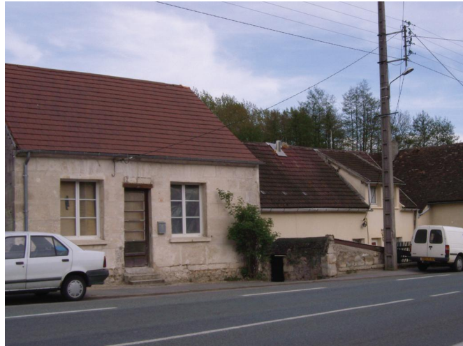
Les matériaux de couverture constituent un enjeu important dans la rénovation ou la réhabilitation des bâtiments. On remarque que la toiture de cette habitation ancienne, route de Guidon, vient d'être refaite en tuiles plates mécaniques, ce qui lui donne un aspect «rigide» par rapport à celles réalisées en tuiles plates traditionnelles.
