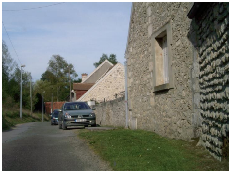
La continuité entre murs, pignons ou façades, est très marquante dans la partie ancienne de Fosse. Une disposition totalement différente des nouvelles implantations réalisées en profondeur.
