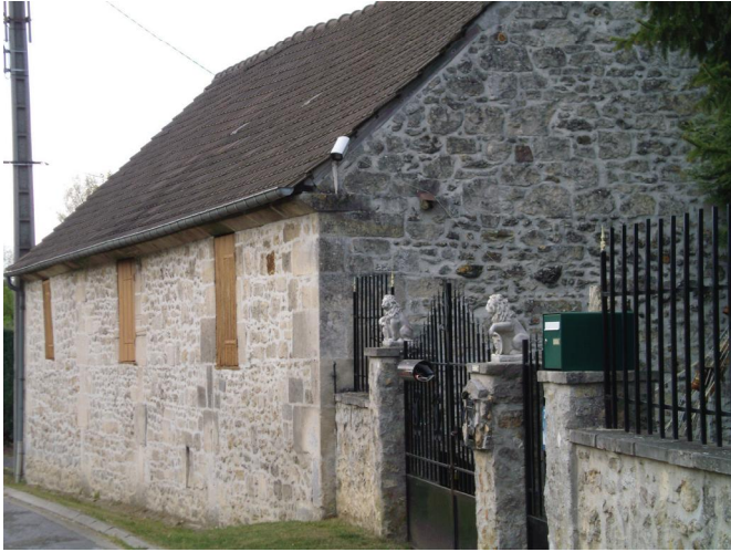
Mur de clôture ancien en continuité d'un bâtiment implanté à l'alignement, route de Guidon. Un système dont la conservation constitue un enjeu.
