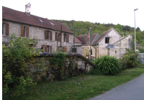
Ces constructions anciennes présentent des implantations plus complexes (façades ou pignons sur rue, accompagnées de dépendances qui forment souvent une cour. Un mur marque la limite sur rue, en continuité avec les bâtiments.
