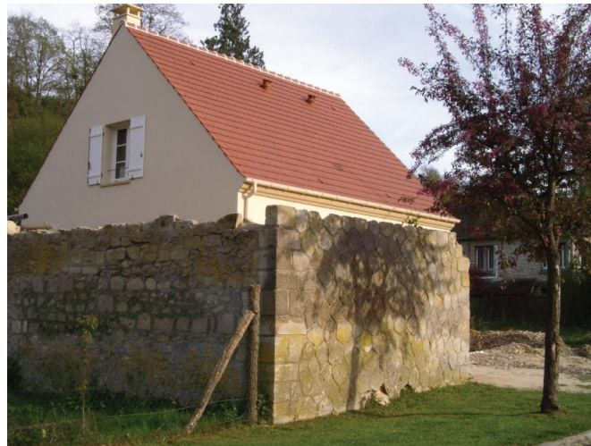
La conservation des murs anciens constitue également un enjeu dans le cadre de l'édification de nouvelles constructions. Ici, le mur d'une construction précédente a été conservé devant cette nouvelle construction. Un exemple à reproduire.
