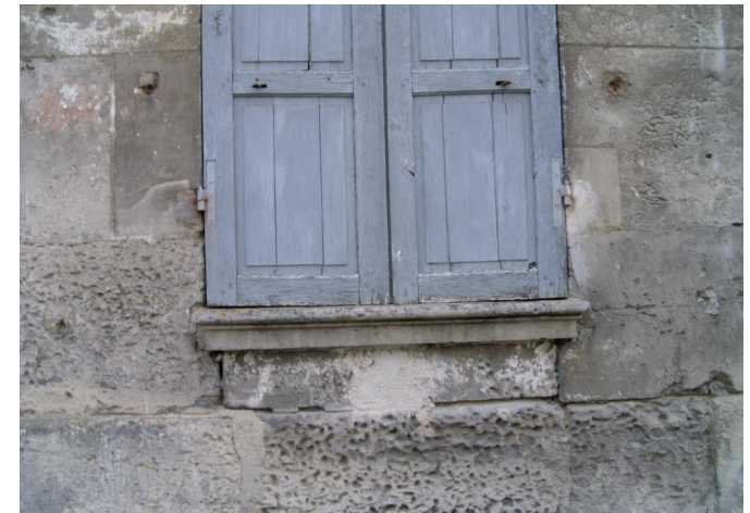
Cette façade comporte des éléments de modénature à mettre en valeur et à entretenir par un nettoyage et un ragréage.
