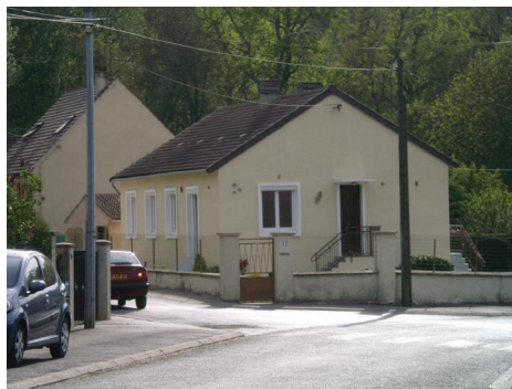
Exemple de construction des années 1960 récemment rénovée, cavée du Roi. La construction est en léger retrait et la façade orientée vers la rue.
