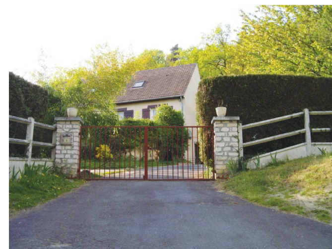
Cette clôture contemporaine, chemin de Fosse, présente un vocabulaire bien différent des murs traditionnels : piliers en fausse maçonnerie, clôture en béton, portail métallique... Leur cadrage réglementaire constitue un enjeu.
